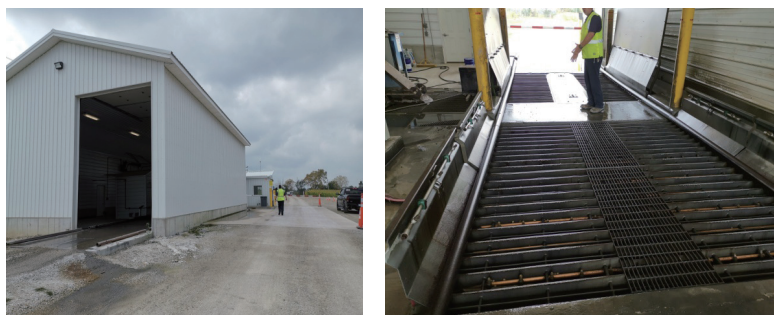
a. 车辆清洗消毒通道外景 (通道外侧设门卫)
